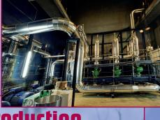
Chaque chaudière est dotée de quatre passages qui sont empruntés par les fumées et les gaz produits par la combustion. Les trois premiers sont verticaux avec des
